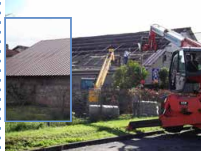
Réfection de la toiture de la salle d'athlétisme et d'aïkido.
