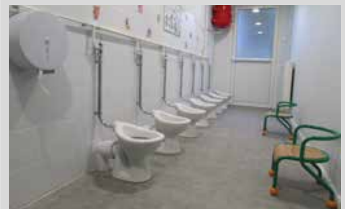
Nouveau bloc WC à la Maternelle du Centre.
