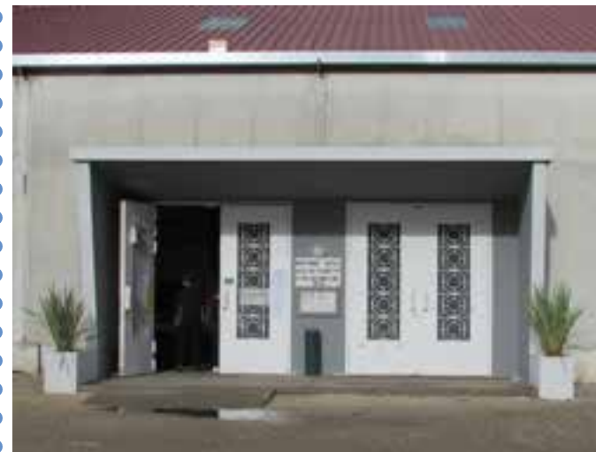
Peinture de la charpente métallique de l'entrée du gymnase. Remplacement du bardage à venir.
