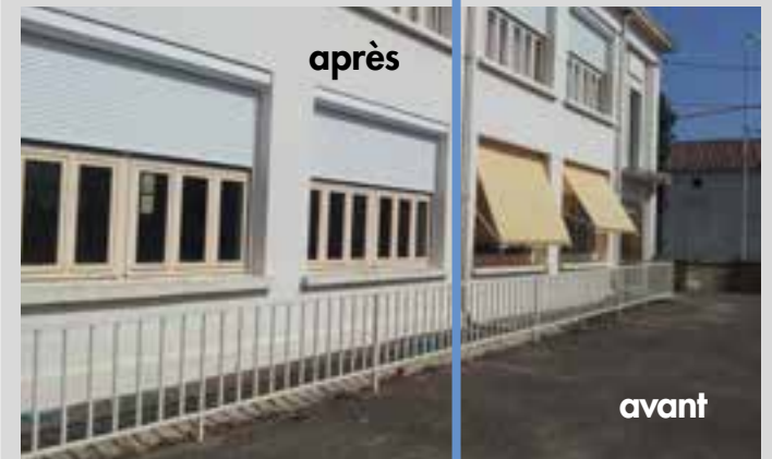
Remplacement des stores de l'école Jean Jaurès par des volets roulants
