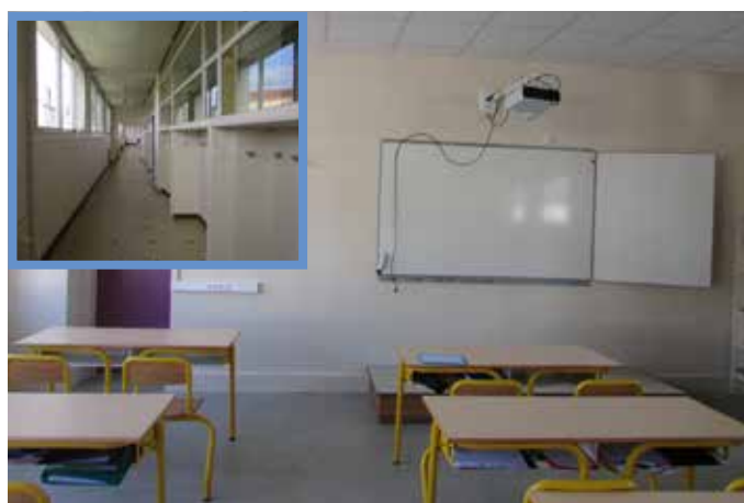
Couloirs : réfection des peintures. Classes : installation d'un tableau blanc numérique, changement du faux-plafond et de l'éclairage d'une classe ...
