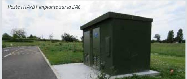
L'opération de desserte engagée en travaux, s'est déroulée en deux phases distinctes. Une première phase pour les travaux d'amenée du réseau électrique HTA jusqu'à la ZA de « LACABLANQUE ». Cette opération a été réalisée par TE 47 en coordination avec une opération de restructuration HTA réalisée par ENEDIS Lot-et-Garonne.
